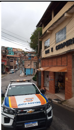
Vista do imóvel próximo ao muro em questão.
