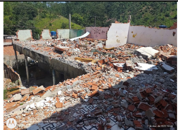
Pavimento superior totalmente demolido
