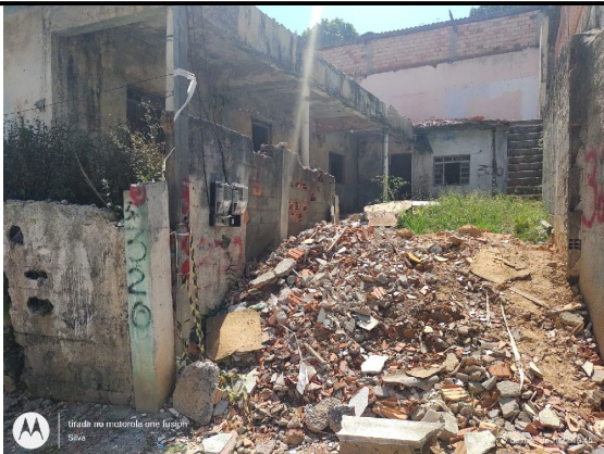
Pavimento inferior parcialmente demolido
