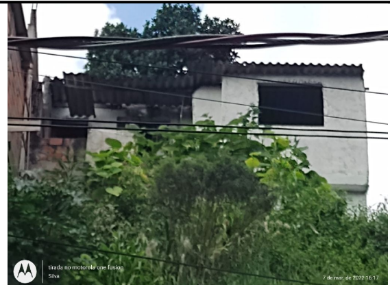
O imóvel ainda em situação de alto risco.
