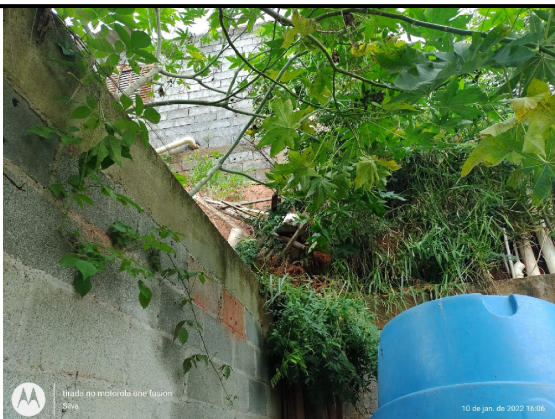
Local já interditado com realização de obra.
