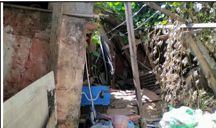
Entulho oriundo do desabamento.
