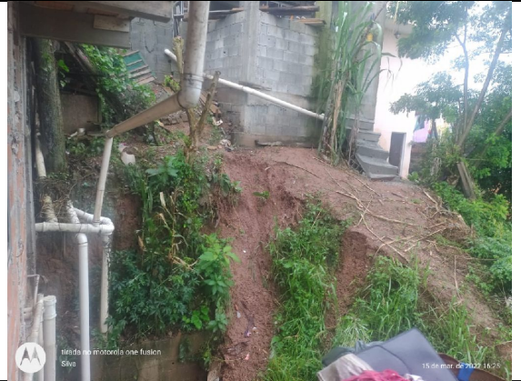
Talude em área de divisa
