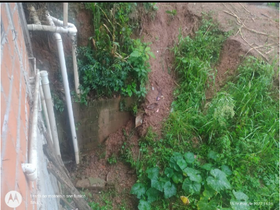
Houve o solapamento de parte do talude lançado
