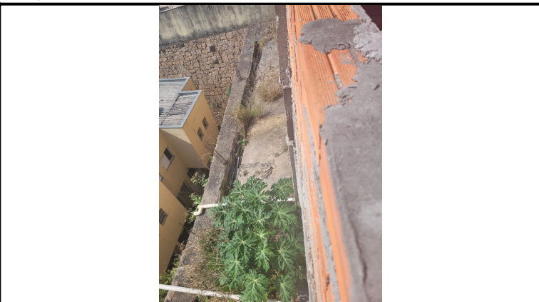
Muro de divisa
