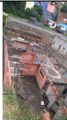
Foto panorâmica da edificação.
