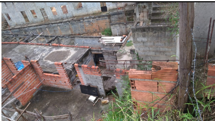
Vista lateral esquerda do imóvel.
