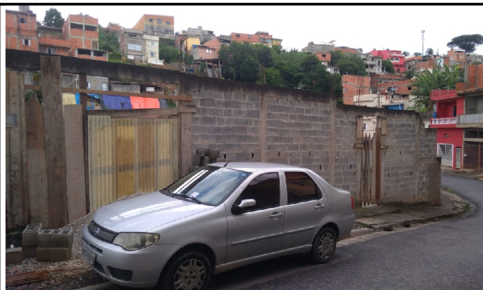
Vista frontal do imóvel.
