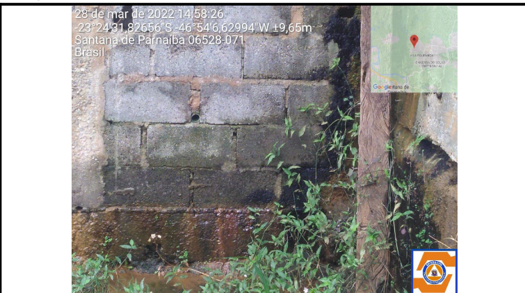
Muro de contenção sem patologias aparente.
