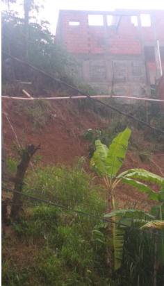
Vista do talude nós fundos.
