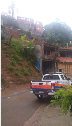
Vista lado esquerdo da edificação.
